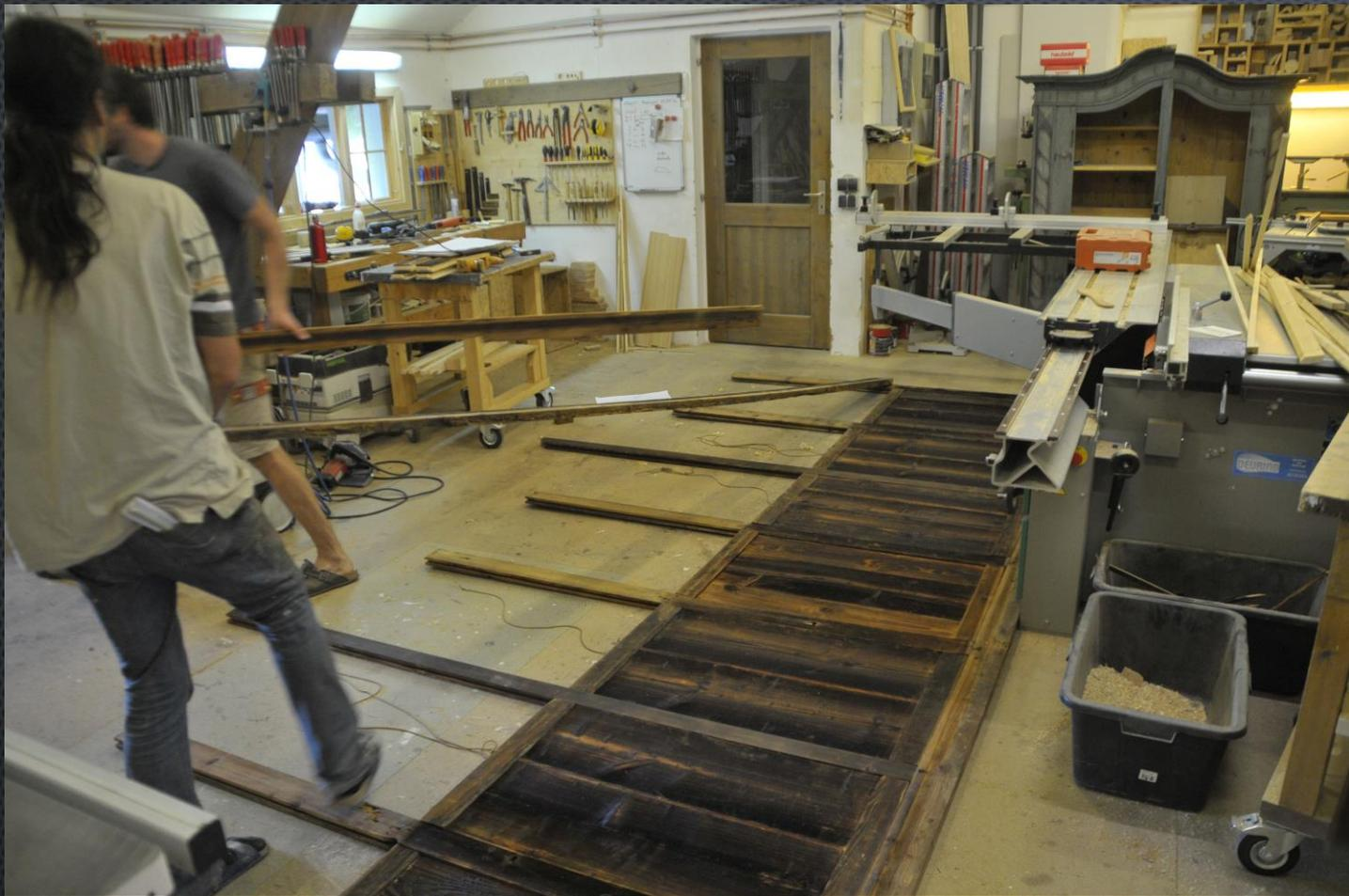
Die komplette Auslegung der Täferkonstruktion in der Werkstatt um die Zapfenpassungen und die verbreiterten Täfer in der Gesamtkonstruktion zu kontrollieren.
