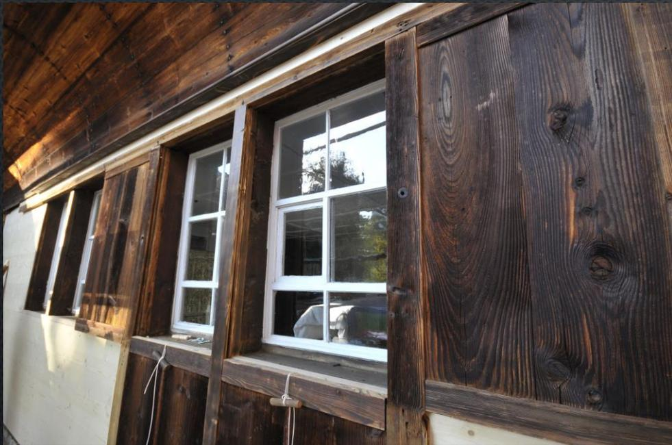
Aufbringen und ausrichten der Laufrahmen für die Zugläden.
