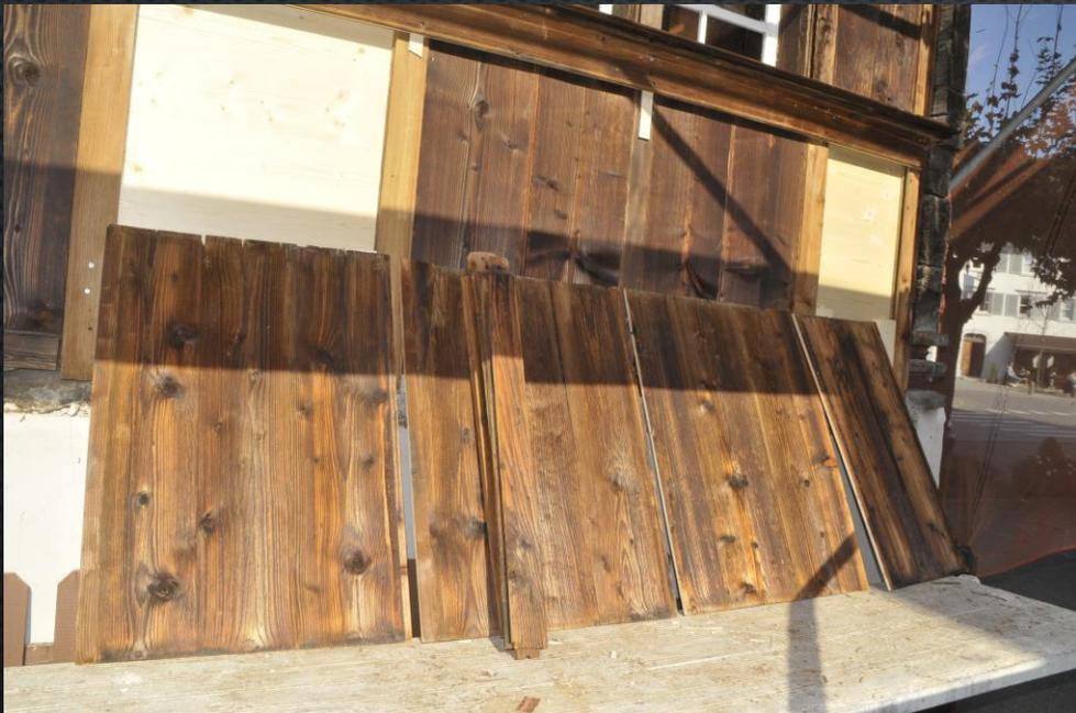
Aufbringung der Sichttäfer auf der Unterkonstruktion der Laufrahmen unterhalb der Fensterfront.
