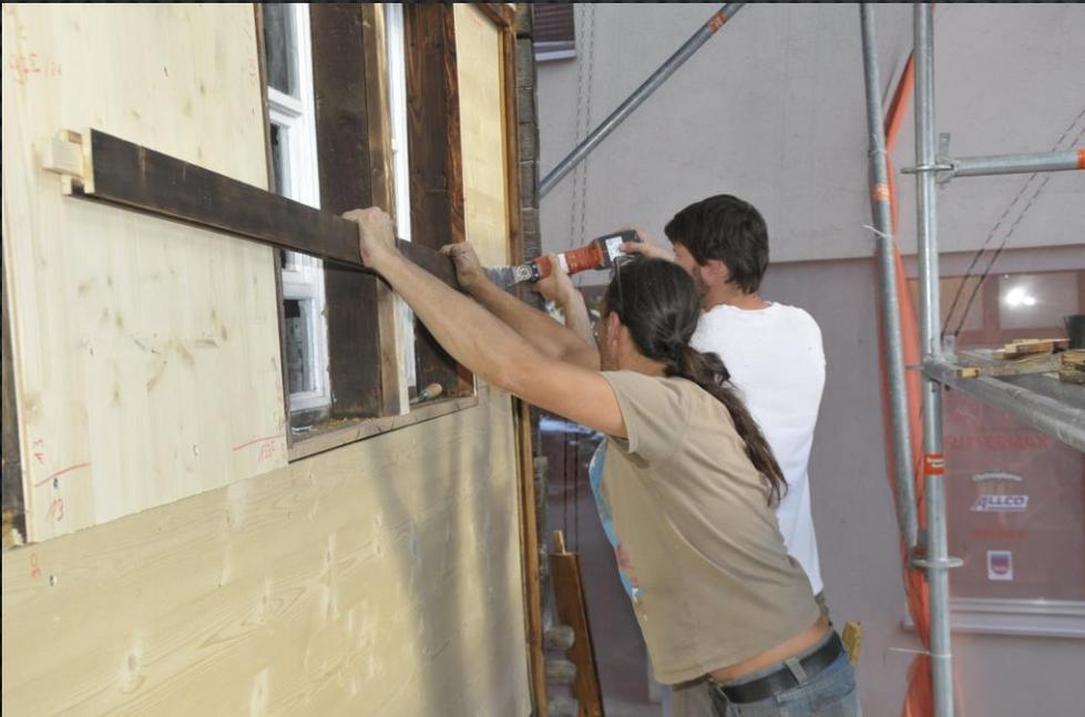
Die Zugläden mit neuem Schubriegel und nach dem Einbau.
