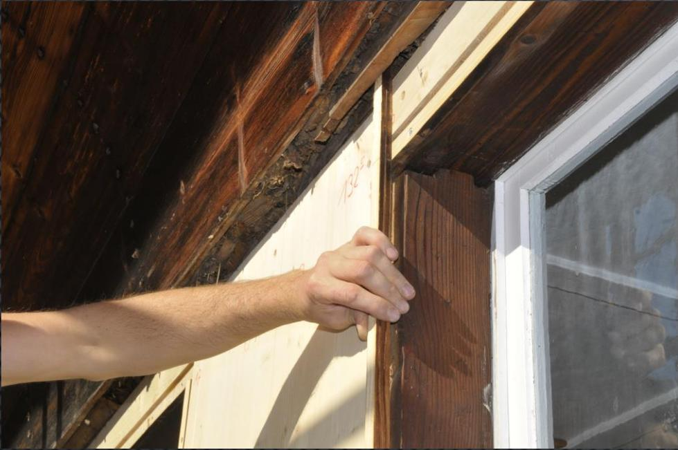
Von der am Bau beteiligten Zimmerei ist die Winddichtigkeit der SW Wand ausgeführt worden. Um die hier zusätzlich aufgebrachte Dreischichtplatte auszugleichen musste in den Fensterleibungen Ausgleichshölzer aufgebracht werden.
