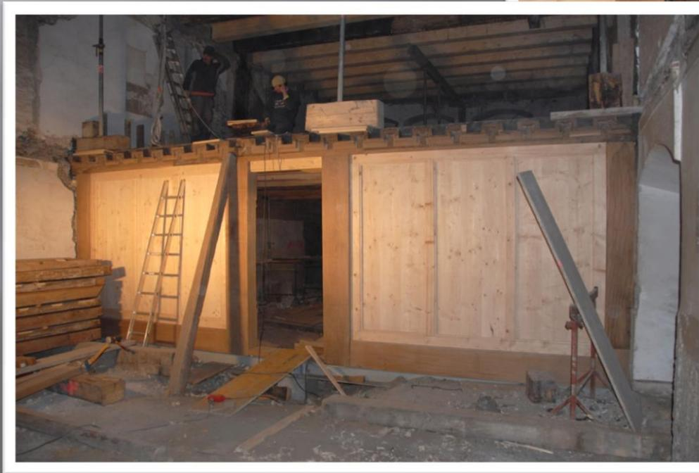
Der zweigeteilte Streichbalken wurde nach Aufstellung der gesamten Wand in den Doppelnut – Zapfen eingelassen. Links unten – der aufgesetzte Balken fertig zum einhängen der Deckenbalken.
