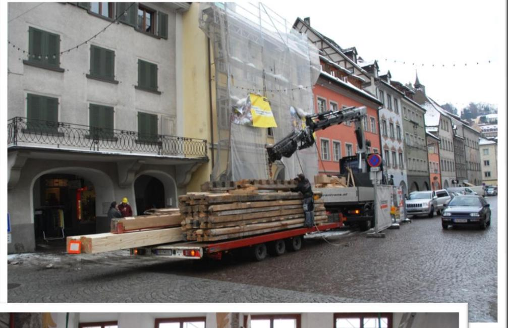
Einbau des inzwischen über 1,1t schweren Streichbalkens. Hierzu wurden drei Kräne eingesetzt. Auf der Rückseite des Streichbalkens befindet sich jetzt eine massive Stahlplatte zur Verbesserung der Statik.
