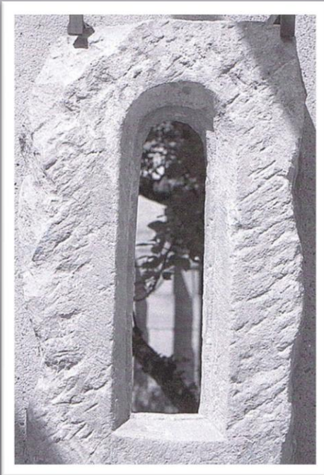
Das aus einem Stück gehauene Steingewände und Arkadenfenster
