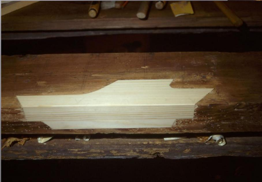
Die Ausspannung sollte Schadensnah erfolgen und in der gleichen Holzart ausgeführt werden.
